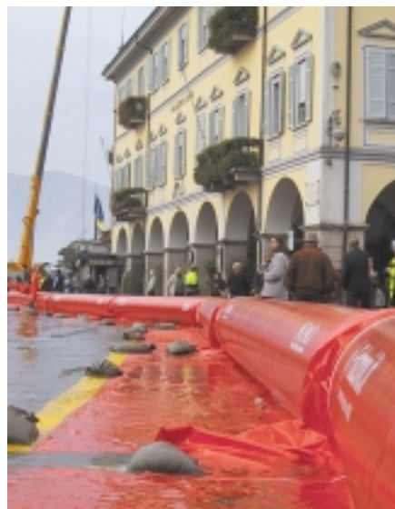
Le barriere mobili antinondazione di Falzoni, in azione durante gli eventi alluvionali che hanno causato un innalzamento del Lago Maggiore tale da minacciare alcuni edifici storici a Verbania
