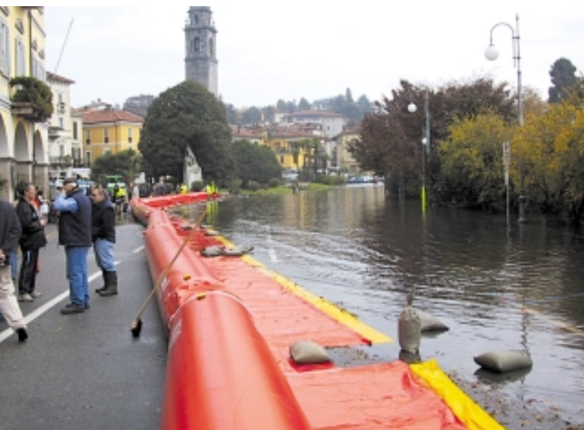
Le barriere mobili antinondazione di Falzoni, in azione durante gli eventi alluvionali che hanno causato un innalzamento del Lago Maggiore tale da minacciare alcuni edifici storici a Verbania
