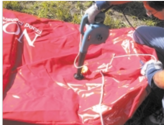
Particolare del soffiatore utilizzato per il riempimento degli elementi
